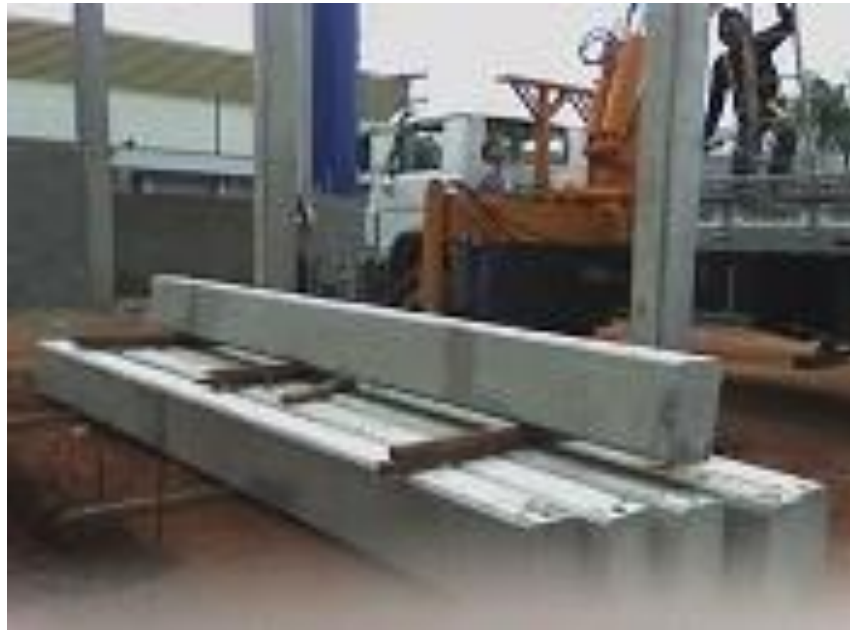
Construção de galpões e áreas de escritórios. Reforma de galpões e escritórios para adequação de novo empreendimento.
