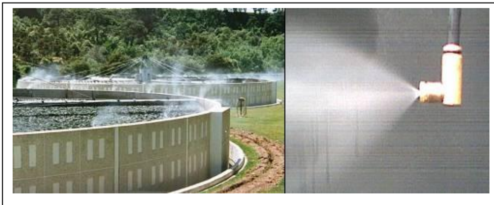
Sistema de desodorização para sistema de tratamento de efluentes utilizando ECOPOL DES10
